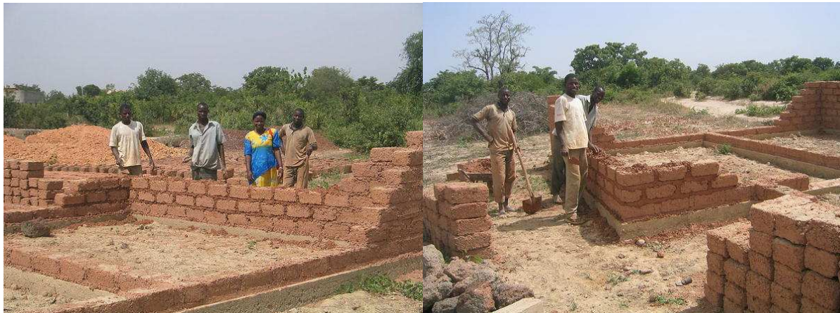
november 2003, de bouw van het eerste eigen STEP huis!
