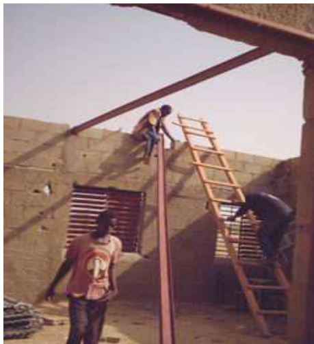
Het begin van de bouw
