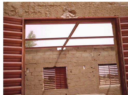
voorjaar 2006 , start bouw dak
