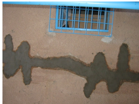
gerepareerde scheur in het STEP huis
